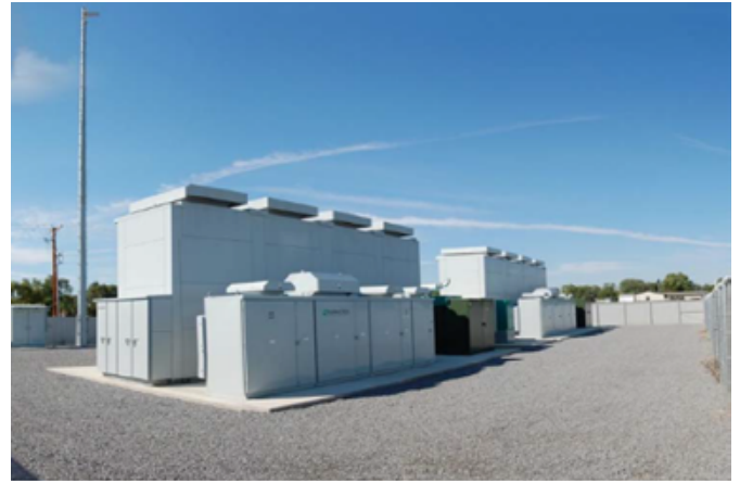
Los bancos de baterías de alta capacidad son un elemento novedoso a los sistemas electricos de potencia
